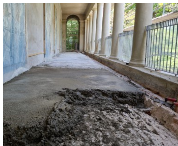
Boltozat fedése könnyű perlitbetonnal
