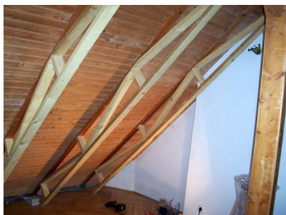
-szigetelési tér kialakítása-
