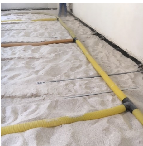
-Feltöltés hidrofób perlitel, dréncsövek lefektetése-
