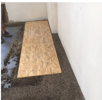
-filcrátés szivárgólemezekre bitumoperlit terítése -
