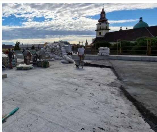
Lapostető lejtésképzése perlitbetonnal
