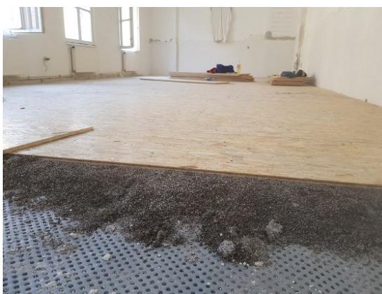
-szárazpadló fektetése-
