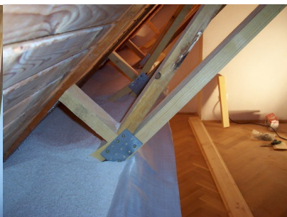
-PdH hidrofób perlit betöltése-
