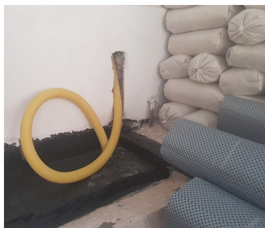
- kiszellőztető csövek kürtőbe kötése-
