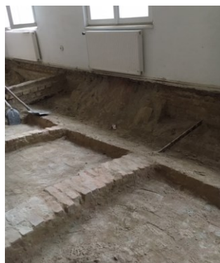
- Az átnedvesedett feltöltés eltávolítása után-
